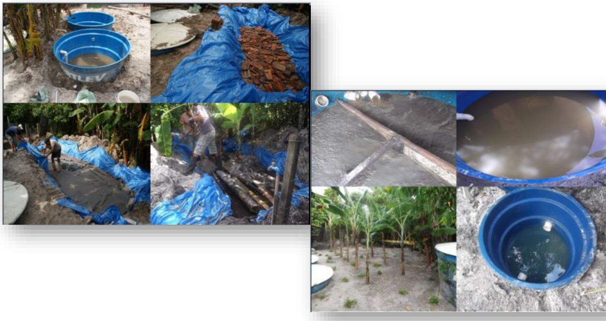
Figura 09. Etapas de construção da zona por raízes.
