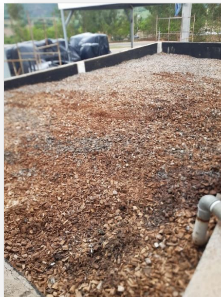
Figura 14. Filtro Biológico com cavacos de pinus na Unidade em Rifaina.
