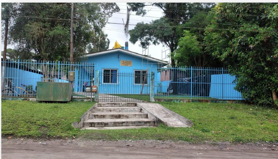
Figura 27. Escola Rural Municipal Prof. Alvina Toledo Pereira. Fonte. Empresa autora do projeto (2021).
